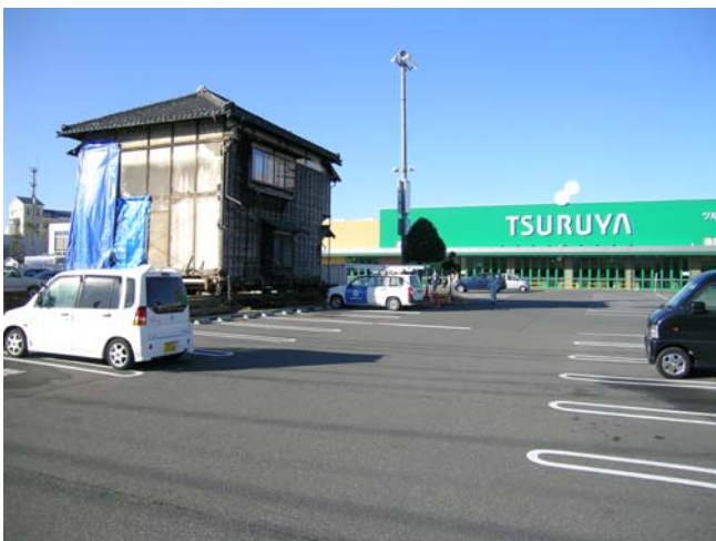
駐車場を移動中。 動き出せば1日数十メートル進む。
