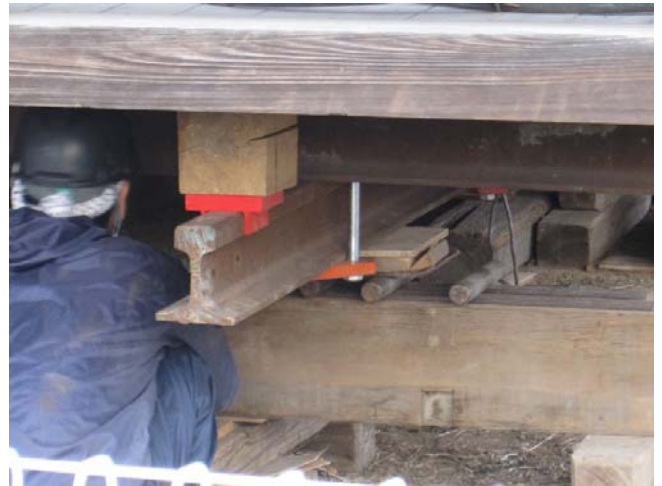
下受け(アンダーピニング)の様子。 鉄のレールや鉄のコロを利用している。
