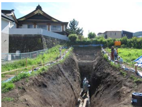
写真-2：岡谷断層のトレンチ調査
