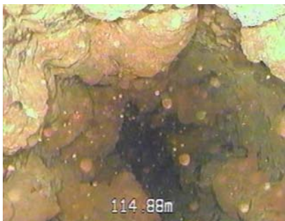
写真-2：井戸内部の状況
