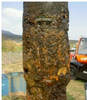
写真-3：ポンプ吸込口
